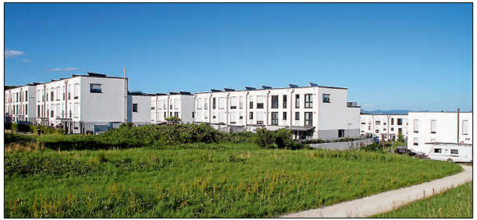
Im Neubaugebiet „Stumpenhof Süd - Talweg“ erinnern einige Gebäude an den Bauhaus-Stil. Die ersten Häuser wurden 2016 errichtet, die letzten werden derzeit fertiggestellt.
